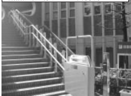
外階段に取り付けられた車椅子用のリフト
