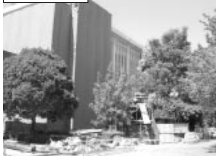
工事中の図書館
